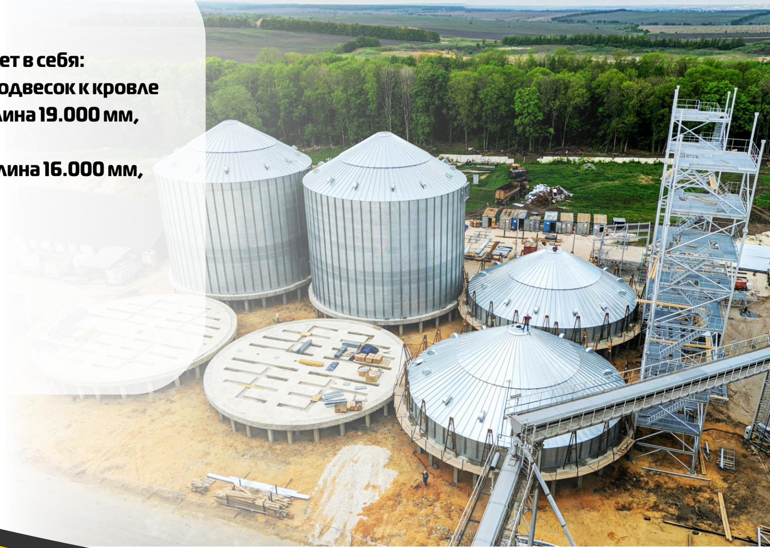
Сектора крыши силоса выполнены из стали марки 350 по ГОСТ 52246-2004 или стали S 350 GD+Z350 толщиной 1,5 мм.
